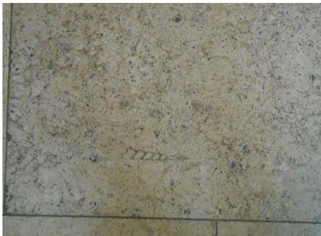
1. Galerie Dvořák, dlažba před vstupem do NORMY
