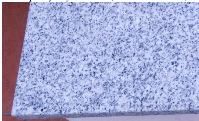
4. Parapet výlohy kovotour (U Černé věže 339)
