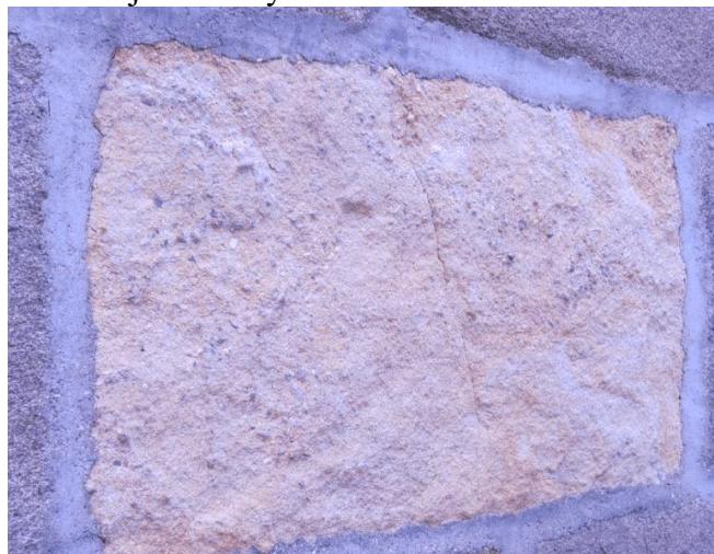
6. Světlejší kameny ve zdivu Černé věže
